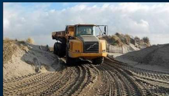
Travaux de création d'un deuxième cordon dunaire. 2015
